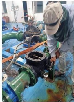
เปลี่ยนตลับลูกปืนและ Mechanical Seal ทำรทำความสะอาดอุปกรณ์ประจำปี
